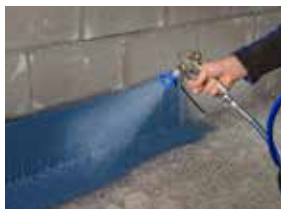
Dichten von unverputzten Wänden oder schadhaftem Putz
