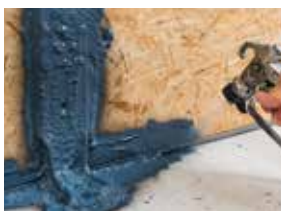
Anschluss Holzbauwände an Betonboden
