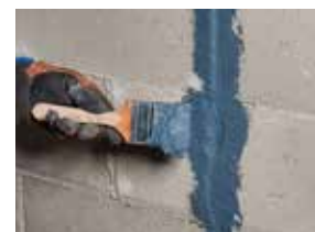
Zustreichen von Rissen bis 20 mm
